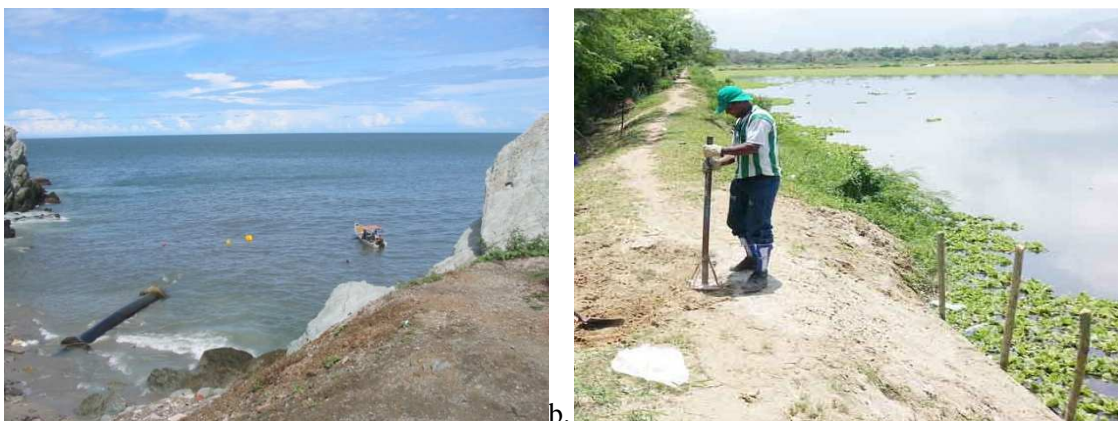
Figura 4.10. Disposición y tratamiento de aguas residuales en municipios del Magdalena. a) Vertimiento directo de las aguas residuales a través del emisario submarino a la Bahía de Santa Marta; b) Laguna de oxidación del municipio de Ciénaga.
