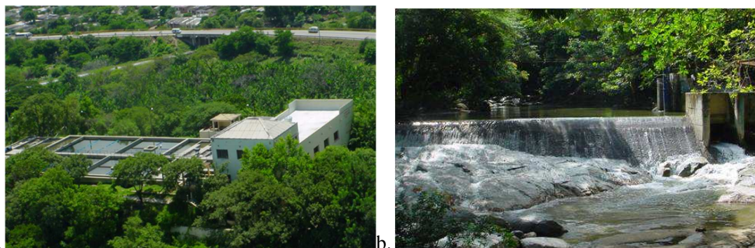
Figura 4.7. Acueducto de Santa Marta Tomada de http://www.metroagua.com.co/wordpress/?page_id=28
